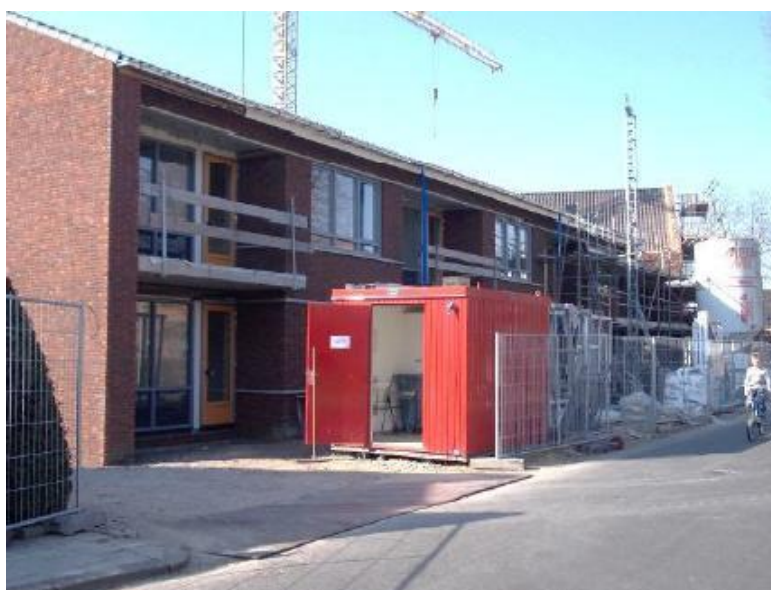
Het in aanbouw zijnde plan In den Herdgang in Meijel
