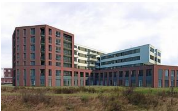
Het project aan het Ringovenpark gebouw H, I en J “de Groenling” heeft in oktober 2013 het hoogste punt bereikt.
